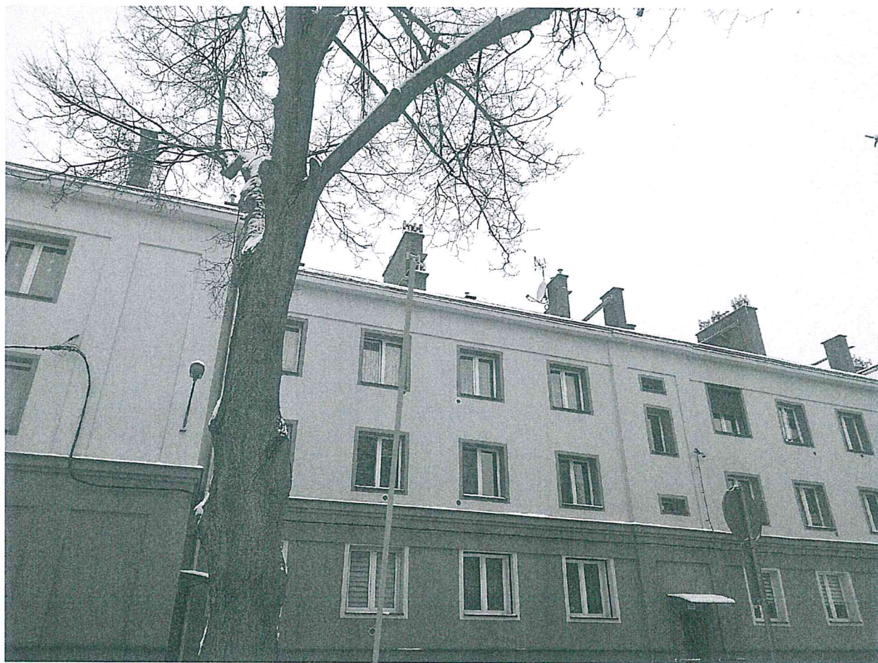
Projektowana nadbudowa przewodów kominowych
